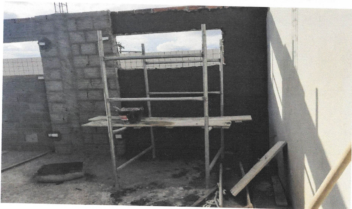
FOTO 16 - CHAPISCO APLICADO EM ALVENARIAS E ESTRUTURAS DE CONCRETO INTERNAS, COM COLHER DE PEDREIRO. ARGAMASSA TRAÇO 1:3 COM PREPARO EM BETONEIRA 400L. AF_06/2014
