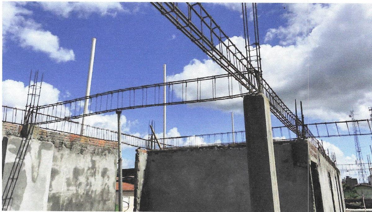
FOTO 08 - ARMAÇÃO DE PILAR OU VIGA DE UMA ESTRUTURA CONVENCIONAL DE CONCRETO ARMADO EM UMA EDIFICAÇÃO TÉRREA OU SOBRADO UTILIZANDO AÇO CA-50 DE 10,0 MM - MONTAGEM. AF_12/2015
