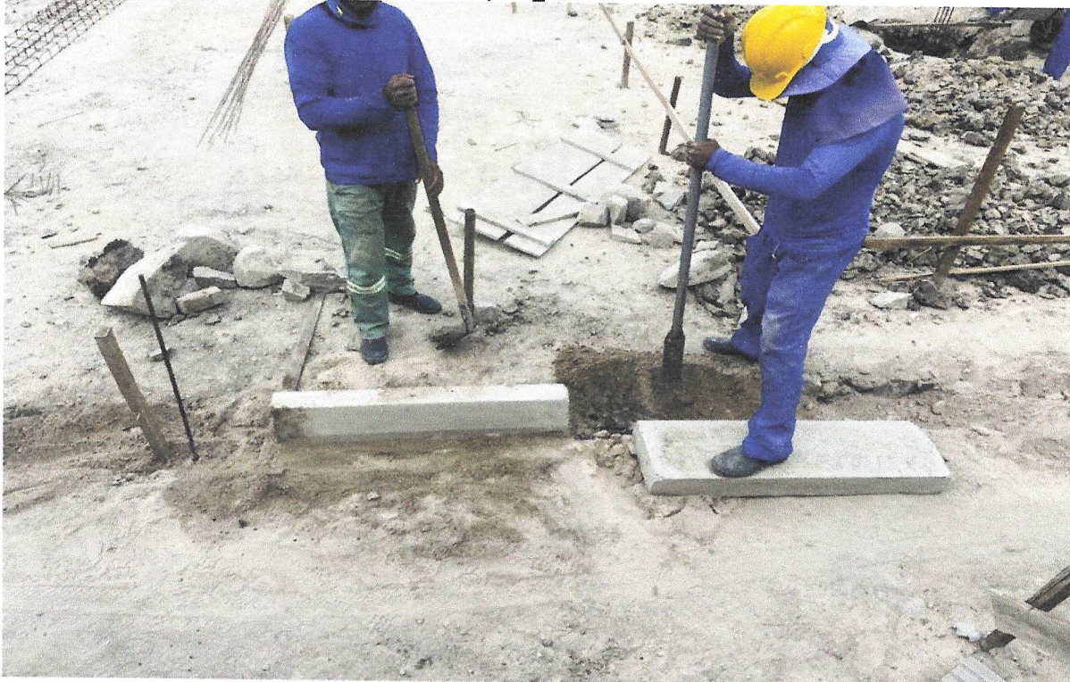
FOTO 54 - ASSENTAMENTO DE GUIA (MEIO-FIO) EM TRECHO RETO, CONFECCIONADA EM CONCRETO PRÉ-FABRICADO, DIMENSÕES 100X15X13X30 CM (COMPRIMENTO X BASE INFERIOR X BASE SUPERIOR X ALTURA), PARA VIAS URBANAS (USO VIÁRIO). AF_06/2016
