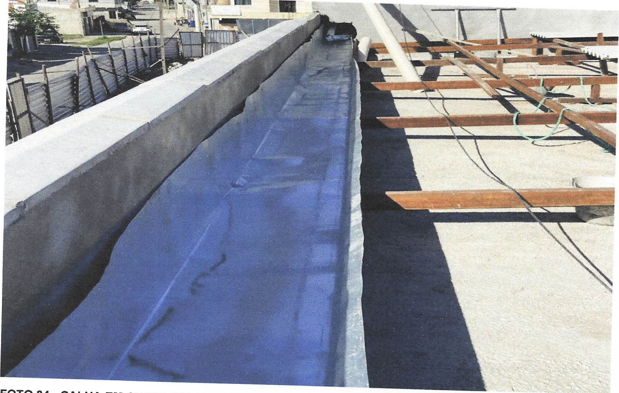
FOTO 34 - CALHA EM CHAPA DE AÇO GALVANIZADO NÚMERO 24, DESENVOLVIMENTO DE 50 CM, INCLUSO TRANSPORTE VERTICAL. AF_07/2019
