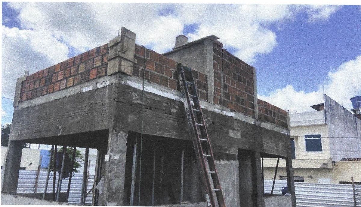
FOTO 42 - CHAPISCO APLICADO EM ALVENARIAS E ESTRUTURAS DE CONCRETO INTERNAS, COM COLHER DE PEDREIRO. ARGAMASSA TRAÇO 1:3 COM PREPARO EM BETONEIRA 400L.
