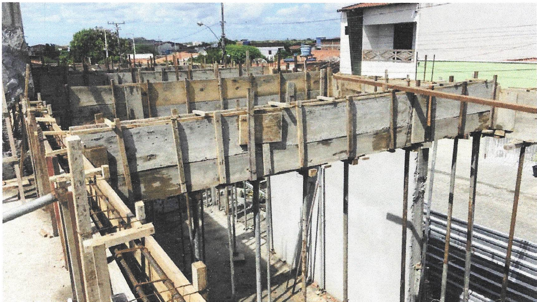
FOTO 02 - FABRICAÇÃO DE FÔRMA PARA VIGAS, EM CHAPA DE MADEIRA COMPENSADA RESINADA, E = 17 MM. AF_09/2020
