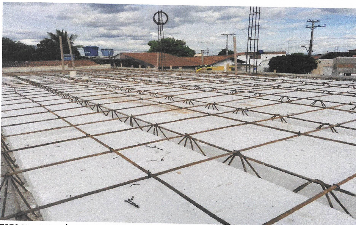
FOTO 38 - LAJE PRÉ-MOLDADA UNIDIRECIONAL, BIAPOIADA, PARA FORRO, ENCHIMENTO EM CERÂMICA, VIGOTA CONVENCIONAL, ALTURA TOTAL DA LAJE (ENCHIMENTO+CAPA) = (8+3). AF_11/2020
