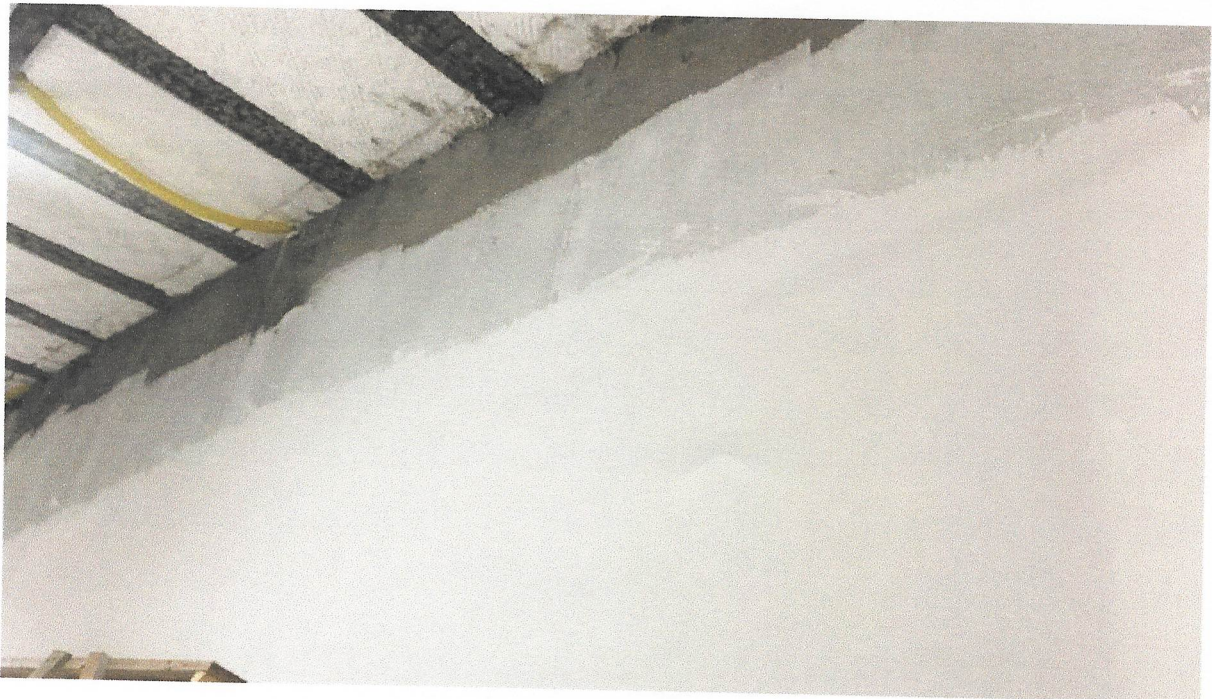
FOTO 30 - APLICAÇÃO DE FUNDO SELADOR ACRÍLICO EM PAREDES, UMA DEMÃO. AF_06/2014
