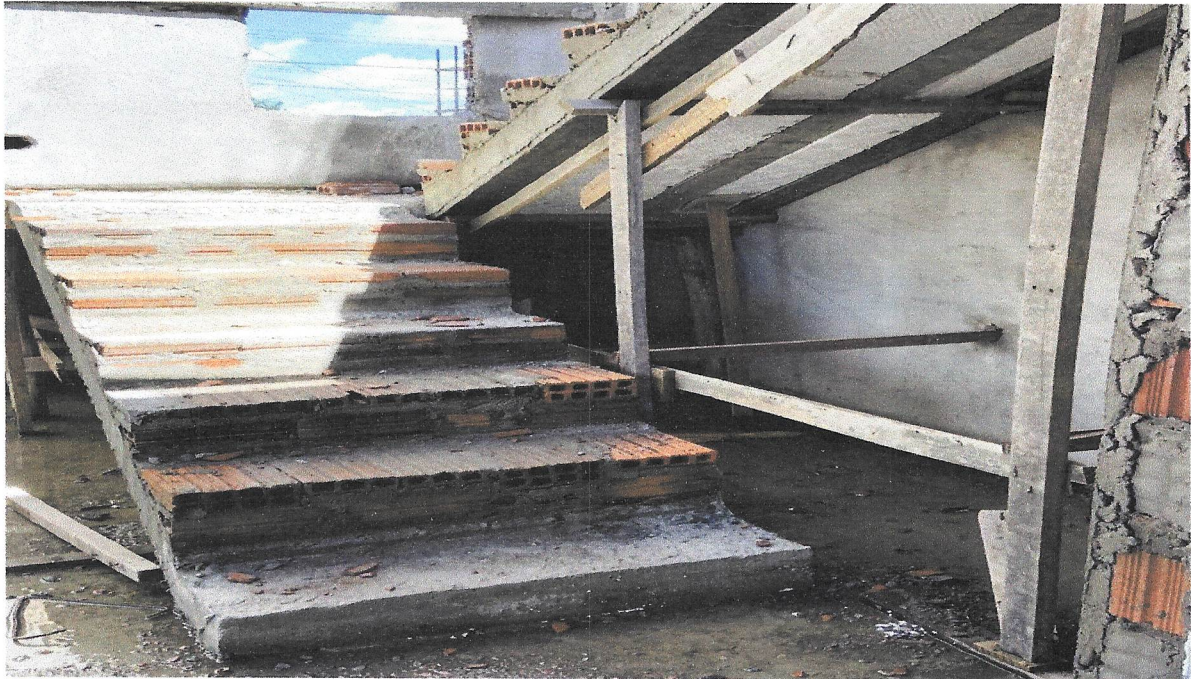
FOTO 04 - FABRICAÇÃO DE FÔRMA PARA ESCADAS, COM 2 LANCES EM "L" E LAJE PLANA, EM CHAPA DE MADEIRA COMPENSADA RESINADA, E= 17 MM. AF_11/2020
