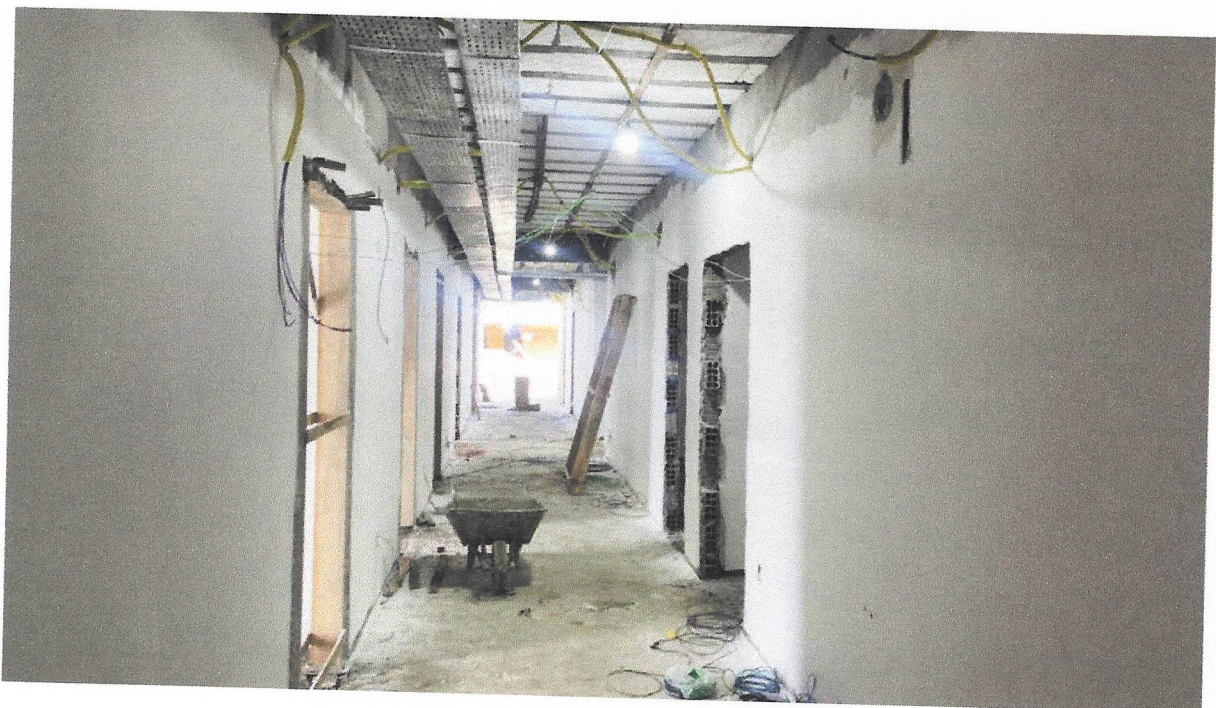
FOTO 32 - EMASSAMENTO COM MASSA A OLEO, DUAS DEMAOS
