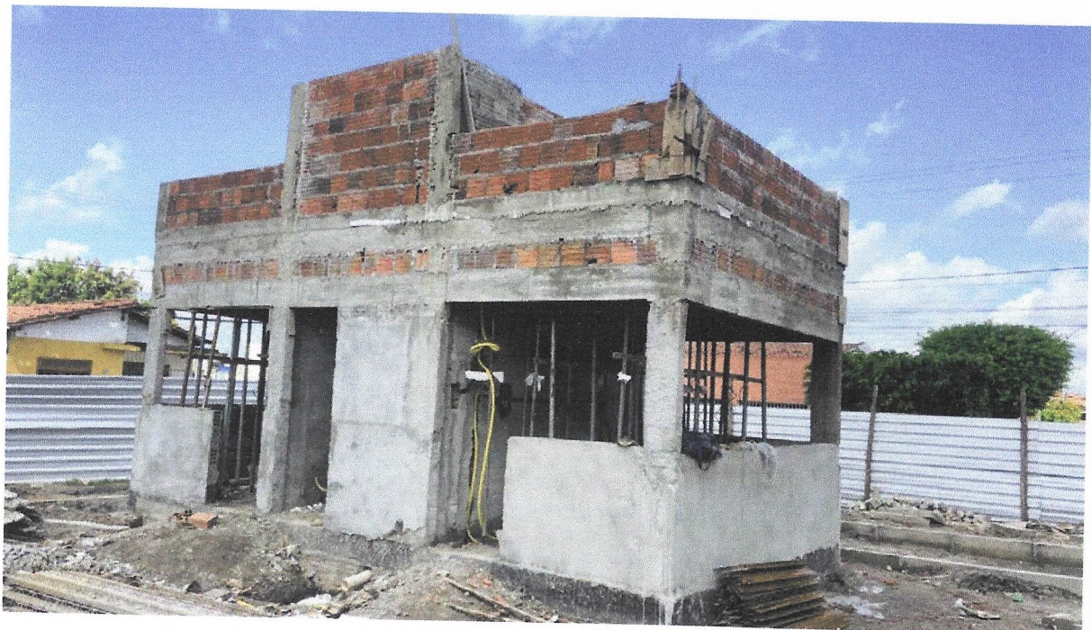
FOTO 36 - (COMPOSIÇÃO REPRESENTATIVA) EXECUÇÃO DE ESTRUTURAS DE CONCRETO ARMADO, PARA EDIFICAÇÃO INSTITUCIONAL TÉRREA, FCK = 25 MPA. AF_01/2017
