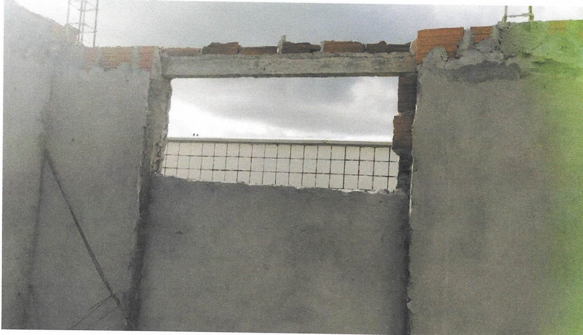
FOTO 12 - VERGA MOLDADA IN LOCO COM UTILIZAÇÃO DE BLOCOS CANALETA PARA JANELAS COM MAIS DE 1,5 M DE VÃO. AF_03/2016
