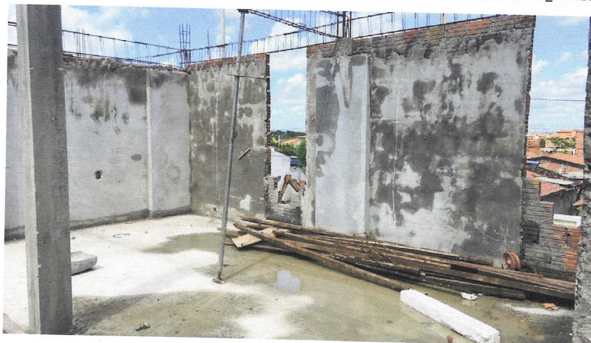
FOTO 10 - ALVENARIA DE VEDAÇÃO DE BLOCOS CERÂMICOS FURADOS NA HORIZONTAL DE 9X19X19 CM (ESPESSURA 9 CM) E ARGAMASSA DE ASSENTAMENTO COM PREPARO EM BETONEIRA. AF_12/2021
