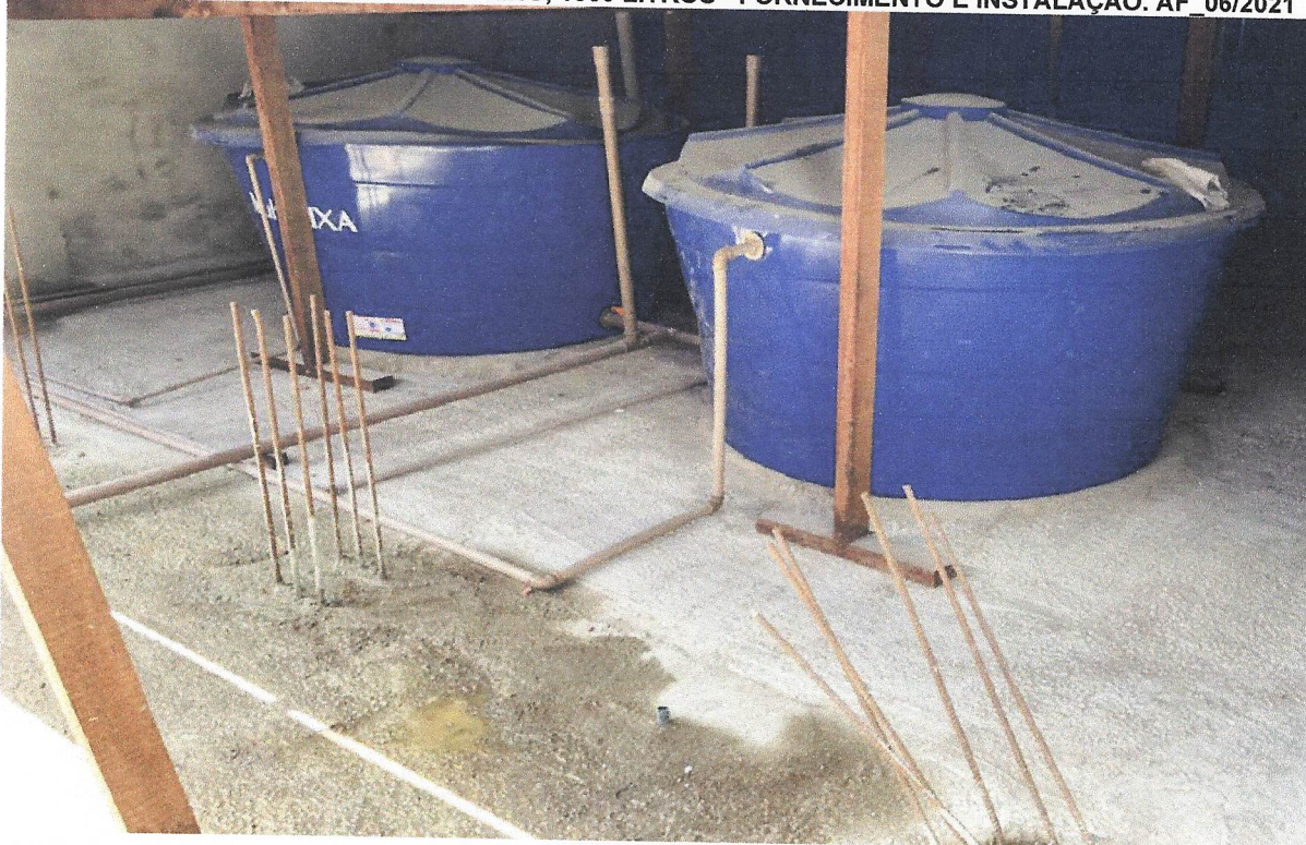
FOTO 46 - CAIXA D'ÁGUA EM POLIETILENO, 1500 LITROS - FORNECIMENTO E INSTALAÇÃO. AF_06/2021
