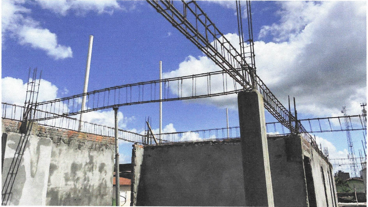
FOTO 06 - ARMAÇÃO DE PILAR OU VIGA DE UMA ESTRUTURA CONVENCIONAL DE CONCRETO ARMADO EM UM EDIFÍCIO DE MÚLTIPLOS PAVIMENTOS UTILIZANDO AÇO CA-60 DE 5,0 MM - MONTAGEM. AF_12/2015
