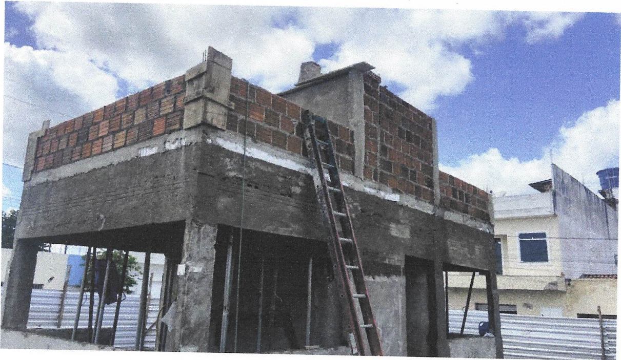
FOTO 36 - (COMPOSIÇÃO REPRESENTATIVA) EXECUÇÃO DE ESTRUTURAS DE CONCRETO ARMADO, PARA EDIFICAÇÃO INSTITUCIONAL TÉRREA, FCK = 25 MPA. AF_01/2017
