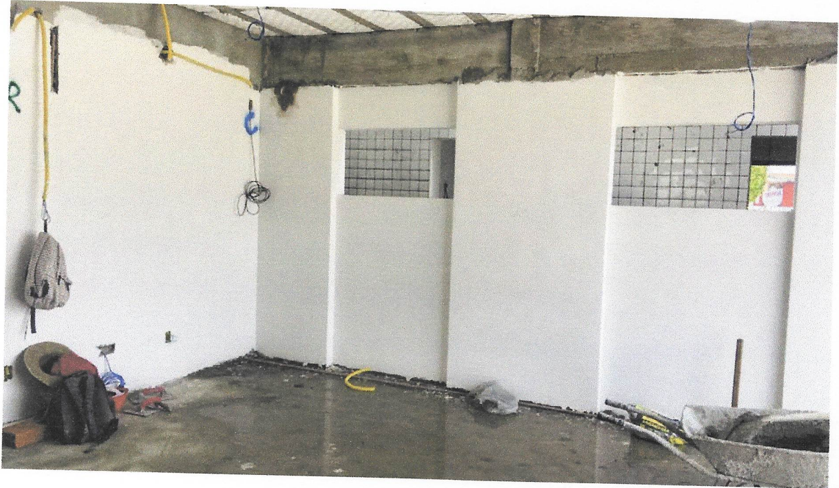
FOTO 32 - EMASSAMENTO COM MASSA A OLEO, DUAS DEMAOS
