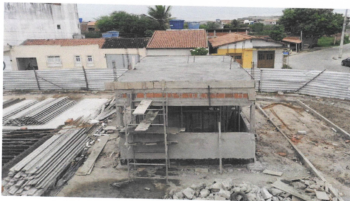
FOTO 38 - LAJE PRÉ-MOLDADA UNIDIRECIONAL, BIAPOIADA, PARA FORRO, ENCHIMENTO EM CERÂMICA, VIGOTA CONVENCIONAL, ALTURA TOTAL DA LAJE (ENCHIMENTO+CAPA) = (8+3). AF_11/2020
