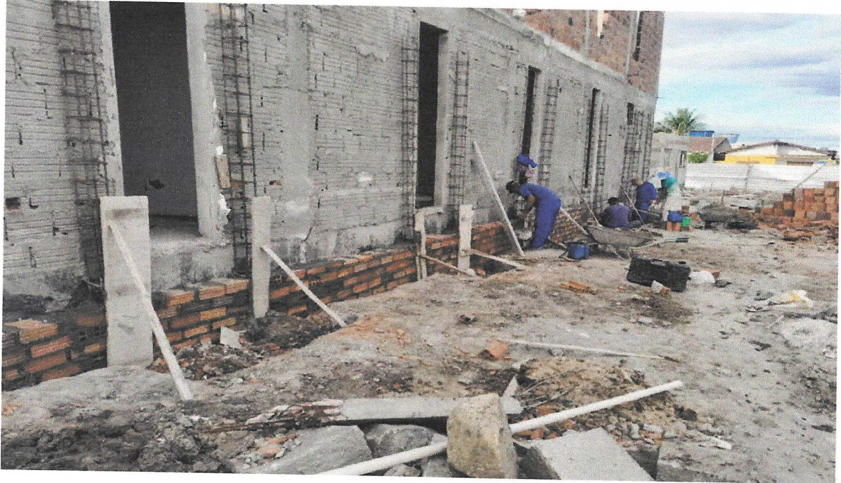
FOTO 24 - CHAPISCO APLICADO EM ALVENARIAS E ESTRUTURAS DE CONCRETO INTERNAS, COM COLHER DE PEDREIRO. ARGAMASSA TRAÇO 1:3 COM PREPARO EM BETONEIRA 400L. AF_06/2014
