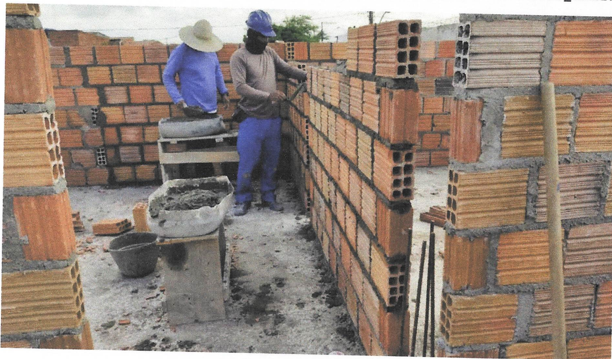
FOTO 10 - ALVENARIA DE VEDAÇÃO DE BLOCOS CERÂMICOS FURADOS NA HORIZONTAL DE 9X19X19 CM (ESPESSURA 9 CM) E ARGAMASSA DE ASSENTAMENTO COM PREPARO EM BETONEIRA. AF_12/2021
