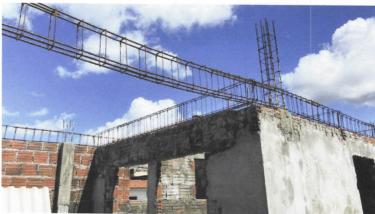
FOTO 08 - ARMAÇÃO DE PILAR OU VIGA DE UMA ESTRUTURA CONVENCIONAL DE CONCRETO ARMADO EM UMA EDIFICAÇÃO TÉRREA OU SOBRADO UTILIZANDO AÇO CA-50 DE 10,0 MM - MONTAGEM. AF_12/2015
