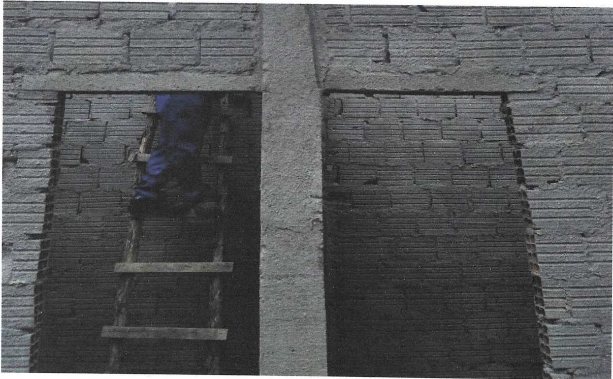
FOTO 14 - VERGA PRÉ-MOLDADA PARA PORTAS COM ATÉ 1,5 M DE VÃO. AF_03/2016
