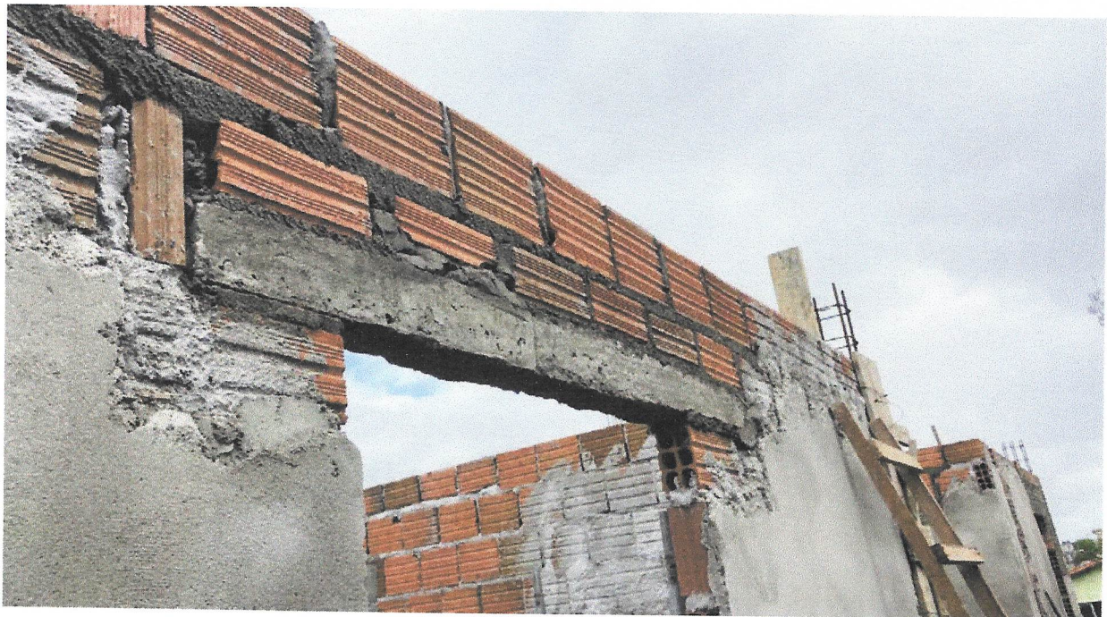
FOTO 14 - VERGA PRÉ-MOLDADA PARA PORTAS COM ATÉ 1,5 M DE VÃO. AF_03/2016
