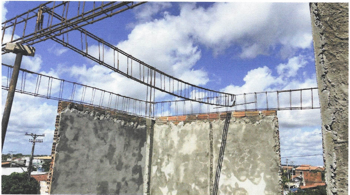
FOTO 06 - ARMAÇÃO DE PILAR OU VIGA DE UMA ESTRUTURA CONVENCIONAL DE CONCRETO ARMADO EM UM EDIFÍCIO DE MÚLTIPLOS PAVIMENTOS UTILIZANDO AÇO CA-60 DE 5,0 MM - MONTAGEM. AF_12/2015
