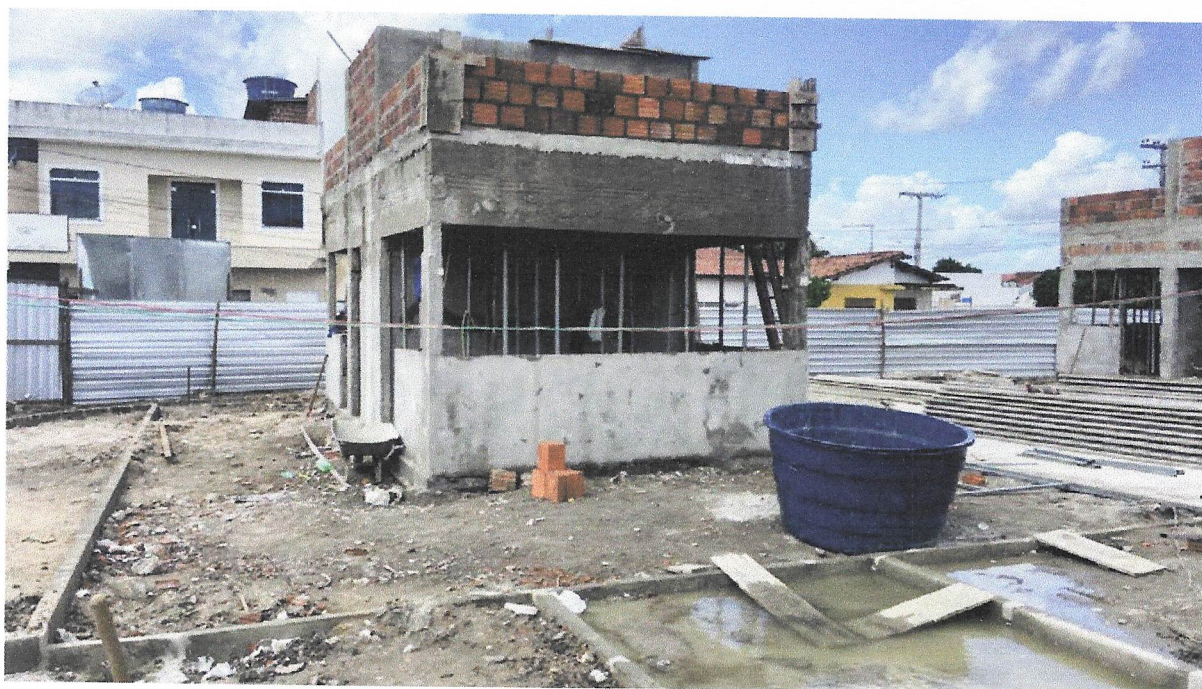
FOTO 42 - CHAPISCO APLICADO EM ALVENARIAS E ESTRUTURAS DE CONCRETO INTERNAS, COM COLHER DE PEDREIRO. ARGAMASSA TRAÇO 1:3 COM PREPARO EM BETONEIRA 400L.
