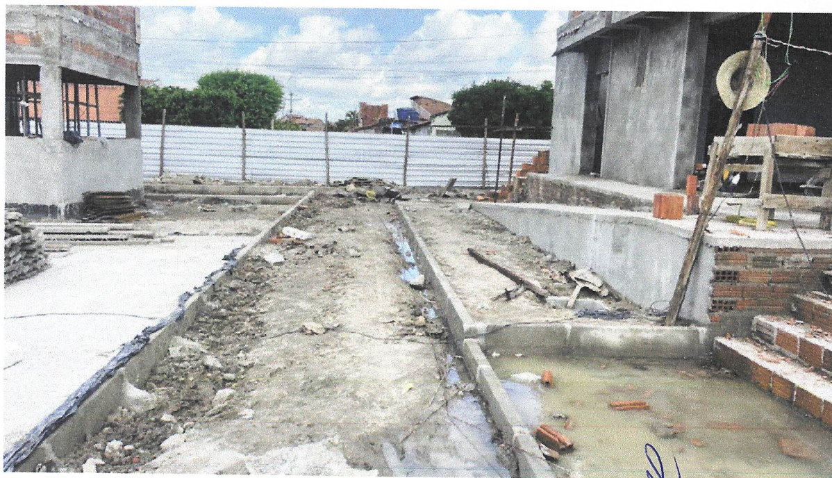
FOTO 54 - ASSENTAMENTO DE GUIA (MEIO-FIO) EM TRECHO RETO, CONFECCIONADA EM CONCRETO PRÉ-FABRICADO, DIMENSÕES 100X15X13X30 CM (COMPRIMENTO X BASE INFERIOR X BASE SUPERIOR X ALTURA), PARA VIAS URBANAS (USO VIÁRIO). AF_06/2016
