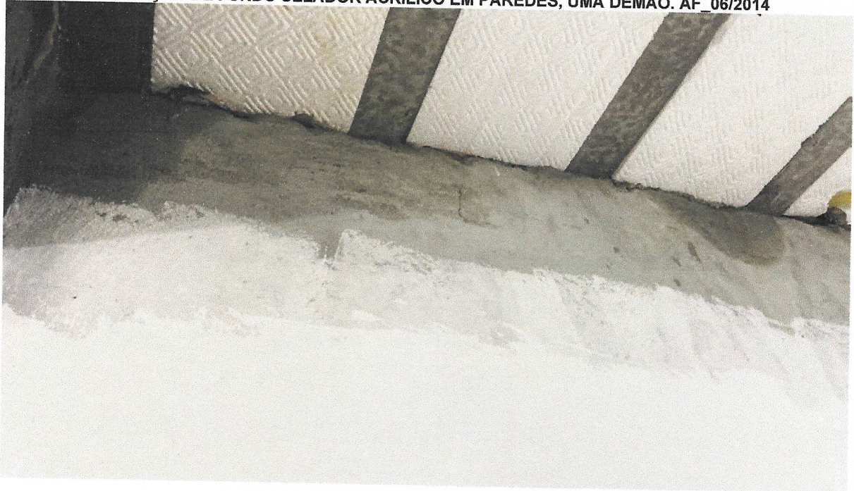
FOTO 30 - APLICAÇÃO DE FUNDO SELADOR ACRÍLICO EM PAREDES, UMA DEMÃO. AF_06/2014
