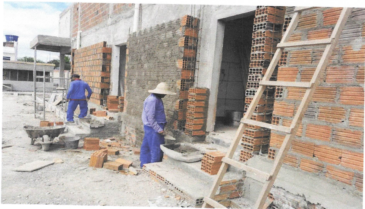
FOTO 24 - CHAPISCO APLICADO EM ALVENARIAS E ESTRUTURAS DE CONCRETO INTERNAS, COM COLHER DE PEDREIRO. ARGAMASSA TRAÇO 1:3 COM PREPARO EM BETONEIRA 400L. AF_06/2014
