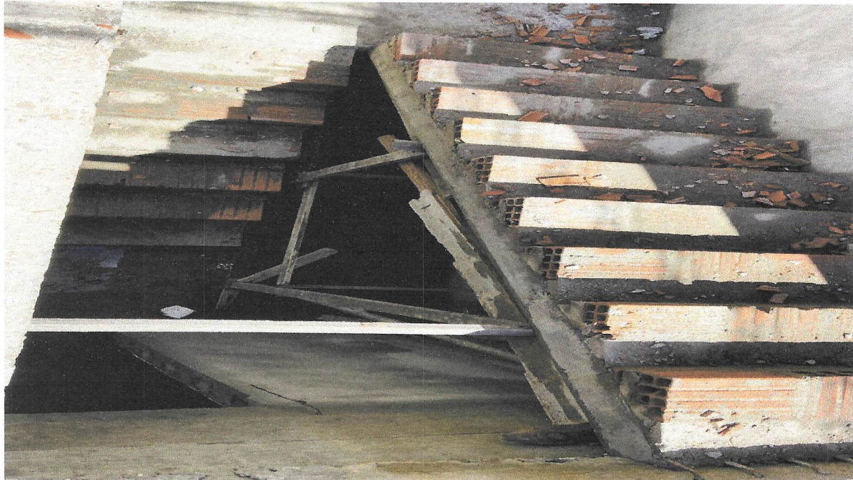
FOTO 04 - FABRICAÇÃO DE FÔRMA PARA ESCADAS, COM 2 LANCES EM "L" E LAJE PLANA, EM CHAPA DE MADEIRA COMPENSADA RESINADA, E= 17 MM. AF_11/2020
