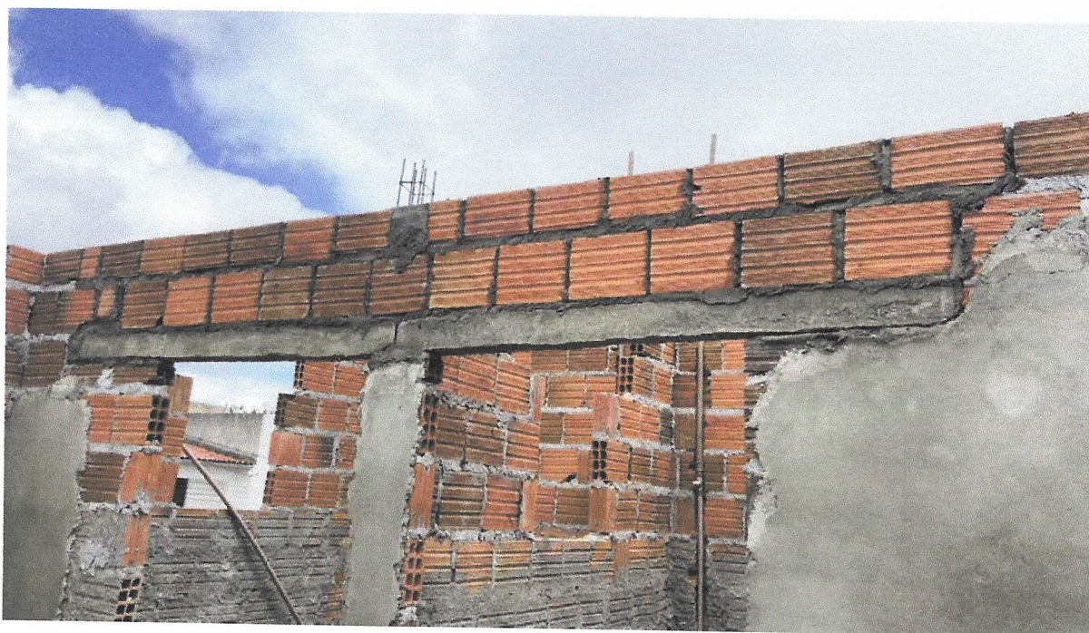
FOTO 12 - VERGA MOLDADA IN LOCO COM UTILIZAÇÃO DE BLOCOS CANALETA PARA JANELAS COM MAIS DE 1,5 M DE VÃO. AF_03/2016
